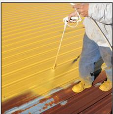
**PASO 2:** Aplique **A-125 Metal Roof Primer** a todo el sustrato antes de recubrir.
