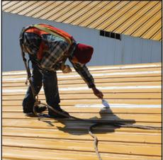
**PASO 3:** Trate las costuras y los sujetadores con **A-200 Flashing Grade**. Las vueltas finales que muestren signos de movimiento deben sellarse con tela de refuerzo de **poliéster** incrustada y cubierta con **A-300 Base**.
