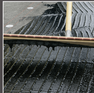
Recubrimiento fibrado de tejado MuleHide #102 aplicándose con un esplechador.
