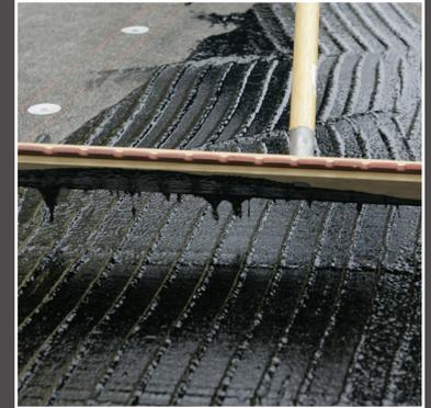
Revestimiento de techo fibrado de piel de mula #102 que se aplica con un rasquetador.
