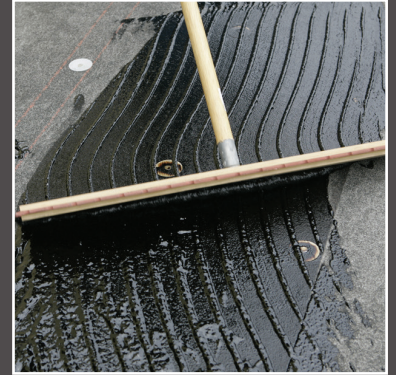
Recubrimiento de tejado MuleHide #111 sin fibras aplicándose con un agua-agua.
