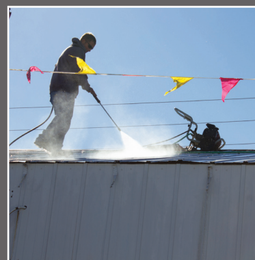
Techo de metal con lavado a presión.
