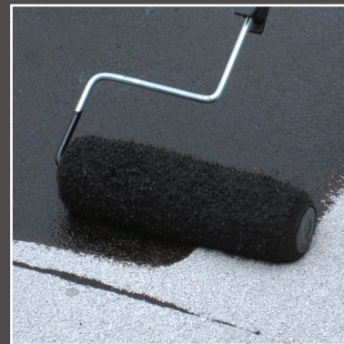
Imprimación MuleHide #121 para asfalto aplicándose con un rodillo.
