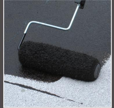
Imprimación asfáltica Mule-Hide #121 que se aplica con un rodillo.
