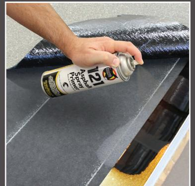
Imprimación de asfalto Mule-Hide #121 que se aplica con una lata de aerosol.
