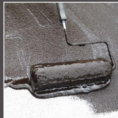
Recubrimiento de MuleHide #311 Emulsion no fibrada para tejado aplicado con un rodillo.
