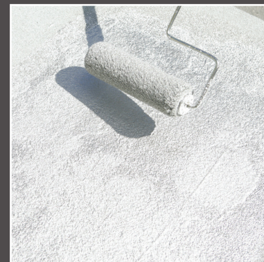
Recubrimiento de tejado de aluminio fibrado premium MuleHide #401 aplicado con un rodillo.
