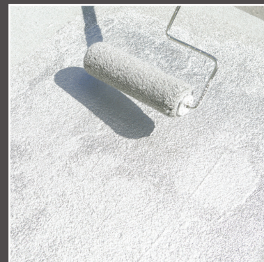
Revestimiento de techo de aluminio fibrado premium Mule-Hide #401 que se aplica con un rodillo.
