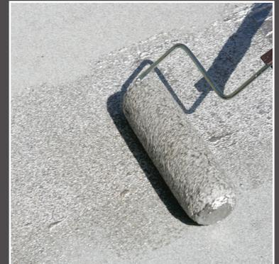
Mule-Hide #406 Revestimiento de techo de aluminio fibrado estándar que se aplica con un rodillo.
