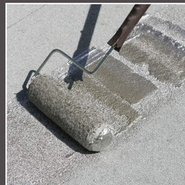
Recubrimiento de tejado de aluminio premium no fibrado MuleHide #410 aplicado con un rodillo.
