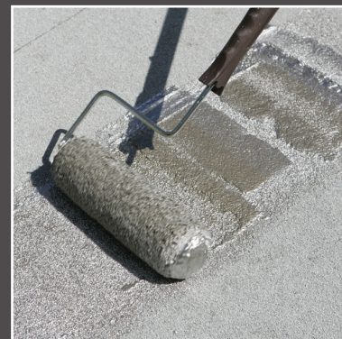
Revestimiento de techo de aluminio no fibrado premium Mule-Hide #410 que se aplica con un rodillo.
