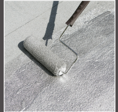
Recubrimiento estándar de tejado de aluminio no fibrado MuleHide #416 aplicándose con un rodillo.
