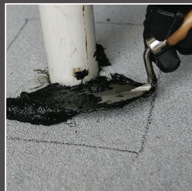
Adhesivo MuleHide #421 Mod Bit – Grado para paleta aplicado con paleta.
