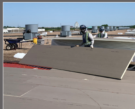
Aplicación de paneles de 4'x12' en la cubierta del tejado.
