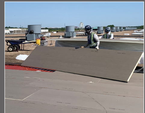
Aplicación de paneles de 4'x12' en la cubierta del tejado.
