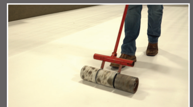
Uso un rodillo de 75 lb para fijar fijamente al sustrato.
