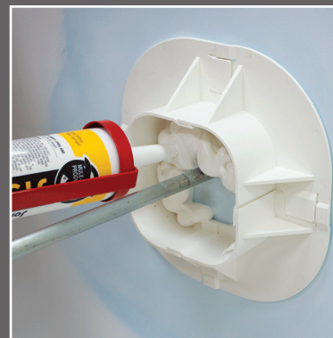
Instalación vertical con JTS 1
