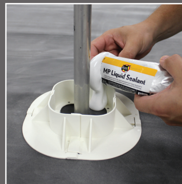
Instalación horizontal con sellador líquido MP
