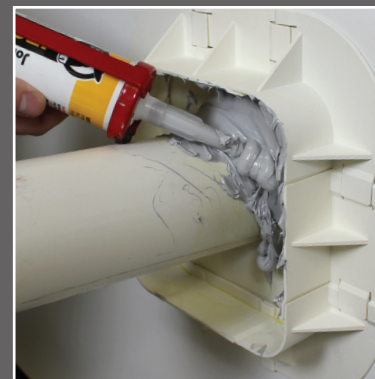
Instalación vertical con JTS 1
