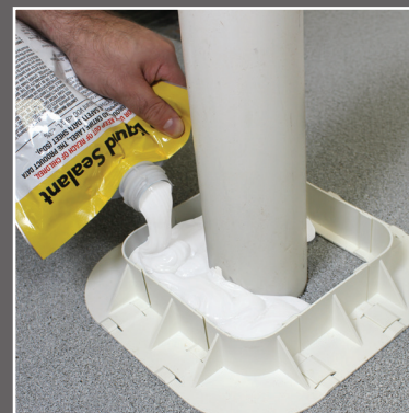
Instalación horizontal con sellador líquido MP
