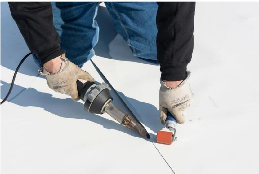
Membrana de TPO de una sola capa fijada mecánicamente y representativa de espesores de 45, 60 y 80 mil
